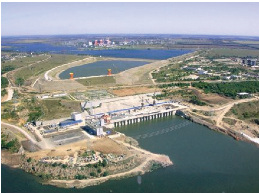
Загальний вигляд Ташлицької ГАЕС (м. Південноукраїнськ), де виконано значний обсяг зміцнювально-реноваційних та гідроізоляційних робіт
