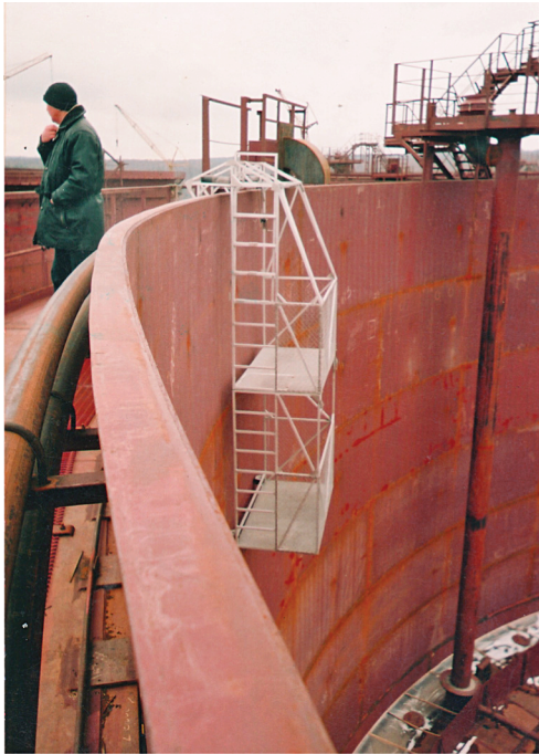
Підготовка до протикорозійного захисту резервуару зберігання нафти на терміналі «Південний» (Одеська обл.)
