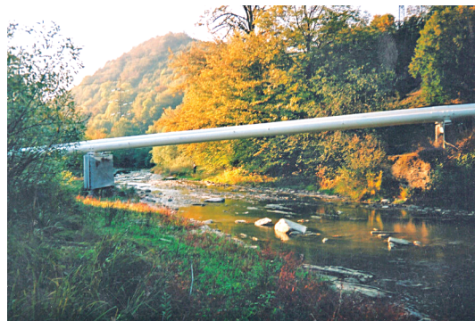
Повітряні переходи компанії «Укртранснафта» з протикорозійним захистом від ДПЦ «Львівантикор»
