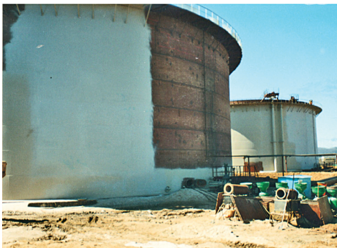
Протикорозійний захист резервуарів зберігання нафтопродуктів нафтопереробного заводу «Нафтохімік Прикарпаття» (Надвірна)
